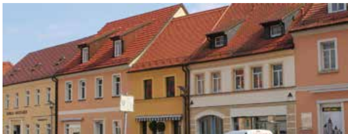
Abb. 3: Der Einzelhauscharakter wird durch den Wechsel unterschiedlicher Gestaltungselemente erreicht. Trotzdem bildet die Häuserzeile ein harmonisches Ganzes durch die Wiederkehr gleicher Fassaden- und Öffnungsproportionen wie die gleichmäßige Reihung stehender Fensterformate.
